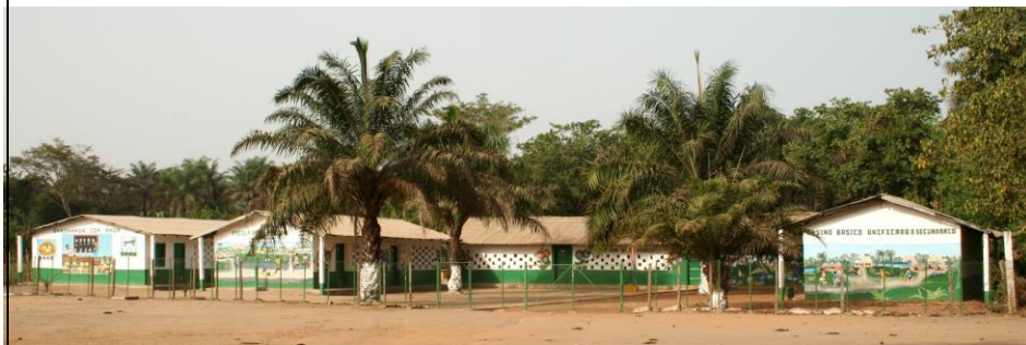
Skolan i Cacine med ny byggnad till vänster med 2 klassrum, förråd och skolhälsovård
